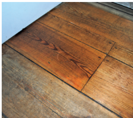
Linoljevax naturell på gammalt trä. Före/Efter behandling.
