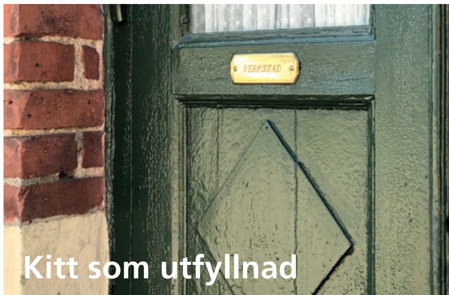
Dörr från 1926. Enkel "fördröja åldrande" åtgärd under 100 år. Linoljekitt i sprickor. Övermålning direkt med ny linoljefärg på åldrad yta.
