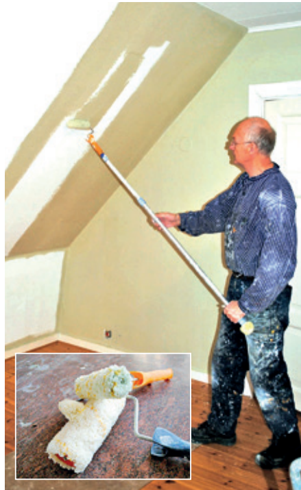
Målning av tapetserade väggar med garnrulle. OBS! Rullen ska rulla lätt! Måla flödigt.
