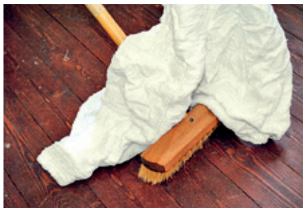
Torka bort överskottet med frottéhandduk.
