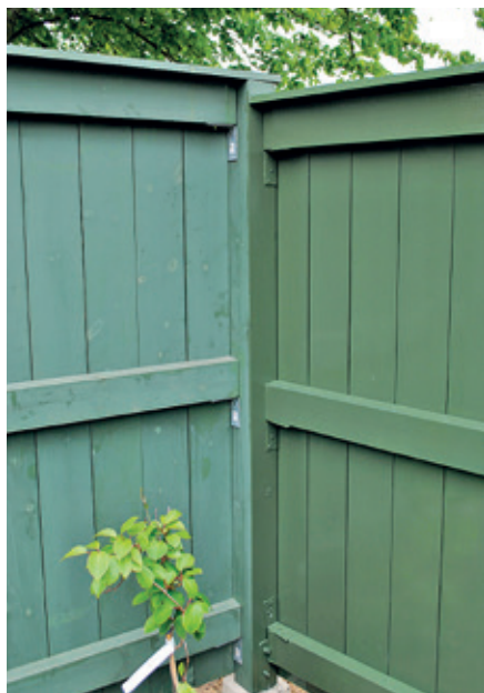
Första respektive andra strykningen. MÅLA FÄRDIGT! Minst 2 gärna 3 fullt täckande skikt.
