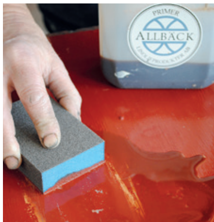
Våtslipa bort "russinskin" med Primer.
