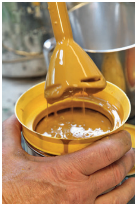
Rör upp färgen nogga med t.ex. stavmixer.
