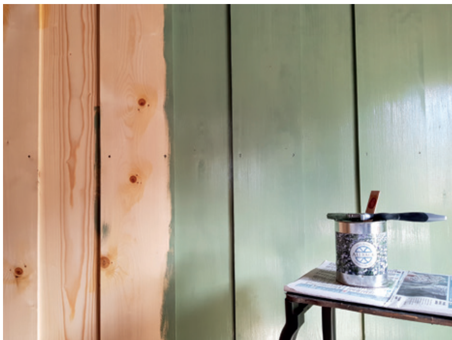
Schellackera kvistar invändigt. Måla ute och inne 2 - 3 strykningar. Kulör Salviagrön.
